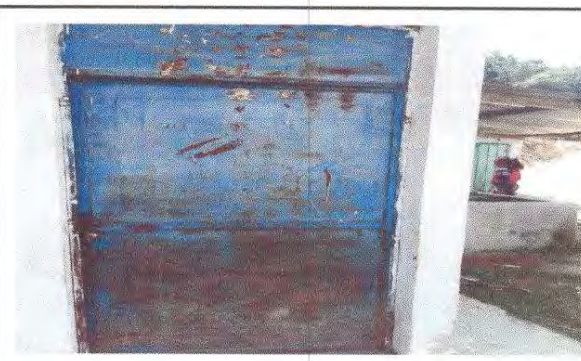
Foto 4: Sustitución de puertas de metal
