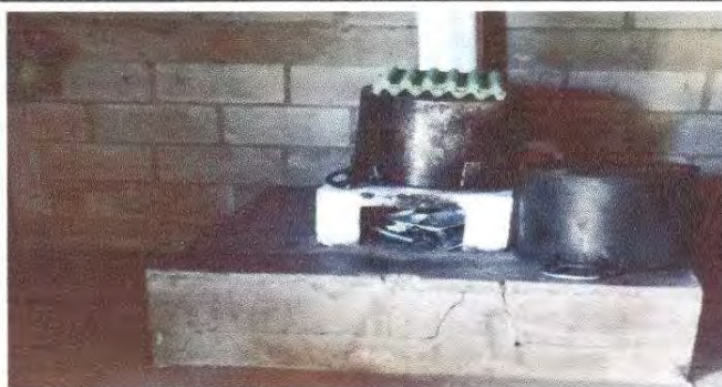
Foto 3: Sustitución de chimeneas
