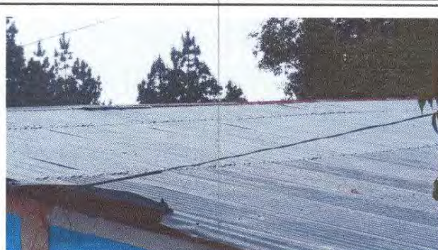
Foto 2: Sustitución de capotes de lamina para lamina troquelada
