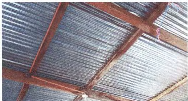
Foto 1: Sustrucción de foco y glafoneras
