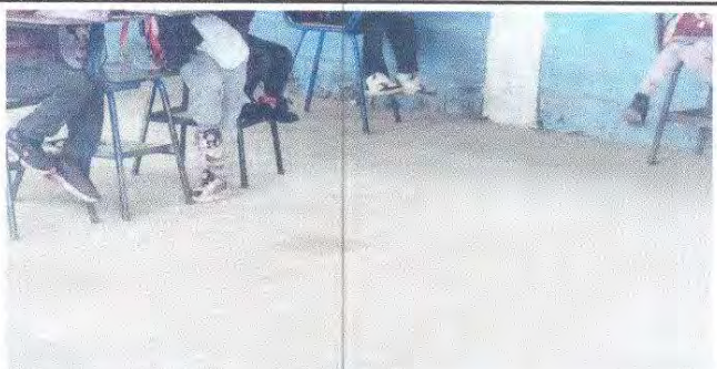
Foto 6: Sustitución de piso cerámico
