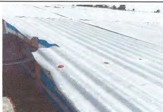
Foto 3: Sustitución de elementos de fijación
