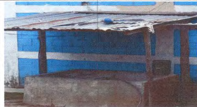
Foto 4: Sustitución de pila de cemento
