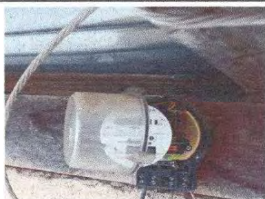
Foto 5: Sustitución de tablero de filepon
